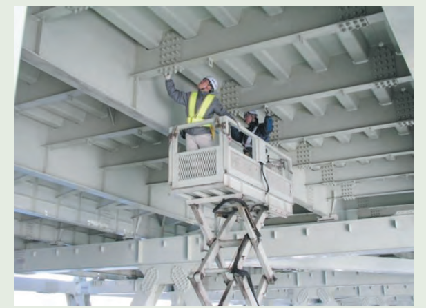
写真15 瀬戸大橋の点検作業
