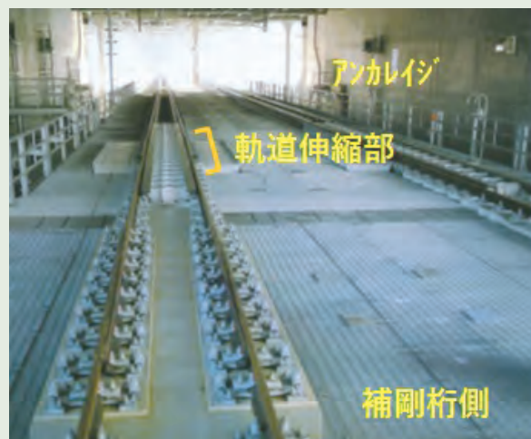
写真11 緩衝桁軌道伸縮装置
