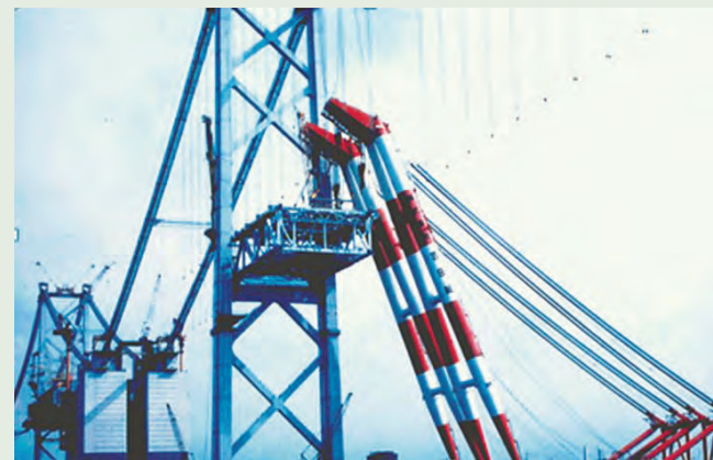
写真8 大型クレーン船による塔付き補剛桁一括架設
