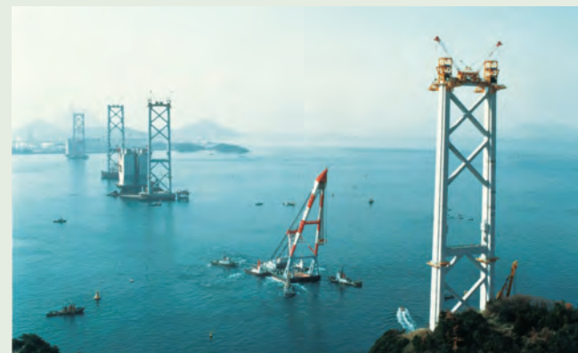
写真7 クレーン船を使用したパイロットロープ渡海
