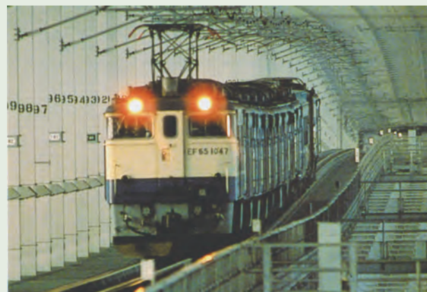
写真13 列車走行試験時の吊橋のたわみ
