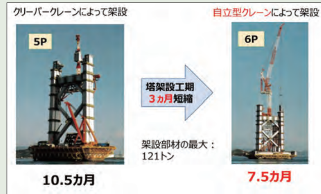
写真6 自立型クレーンによる塔架設の工期短縮
