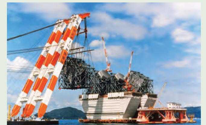
写真5 ケーブルアンカーフレームの一括架設（4A）
