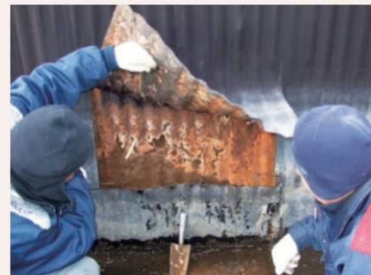
写真6 鋼製コルゲートフリーウムの腐蝕
