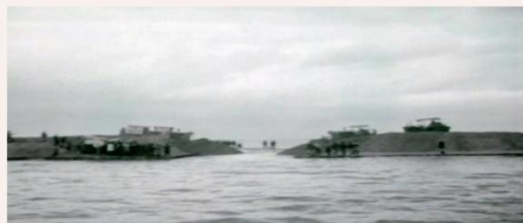
写真4 中央干拓堤防の締め切り
