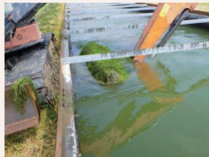
写真7 幹線用水路の沈水植物
