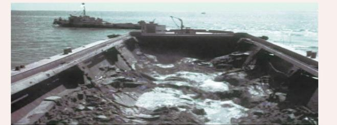
写真3 曳航式底開き土運船の捨土中の状況
