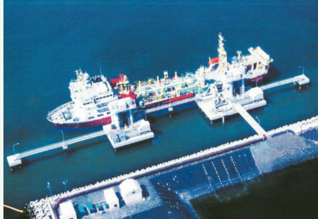
写真3 土砂排出のため着岸した海翔丸
