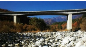
写真 14 中田切川橋(P C橋)
