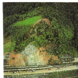
写真 7 大野地区法面崩壊
