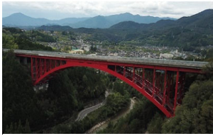
写真 13 落合川橋(鋼ローゼ橋)
