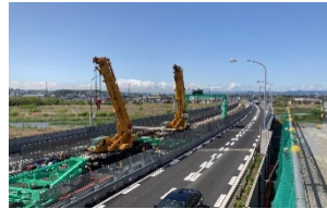
写真 15 橋梁リニューアル工事
