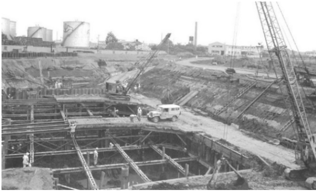
写真4 浮間処理場の建設
