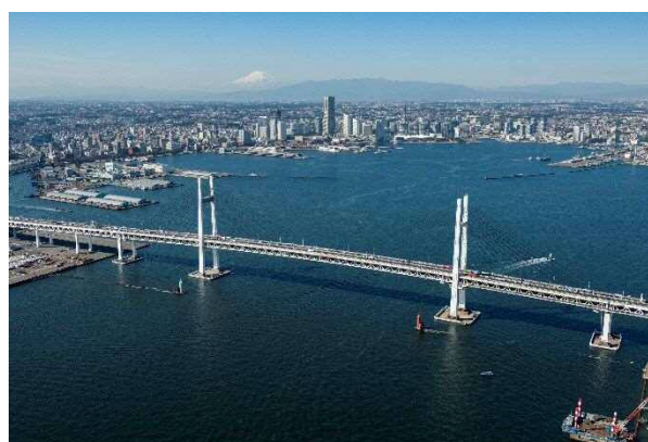
写真-1 横浜ベイブリッジ
