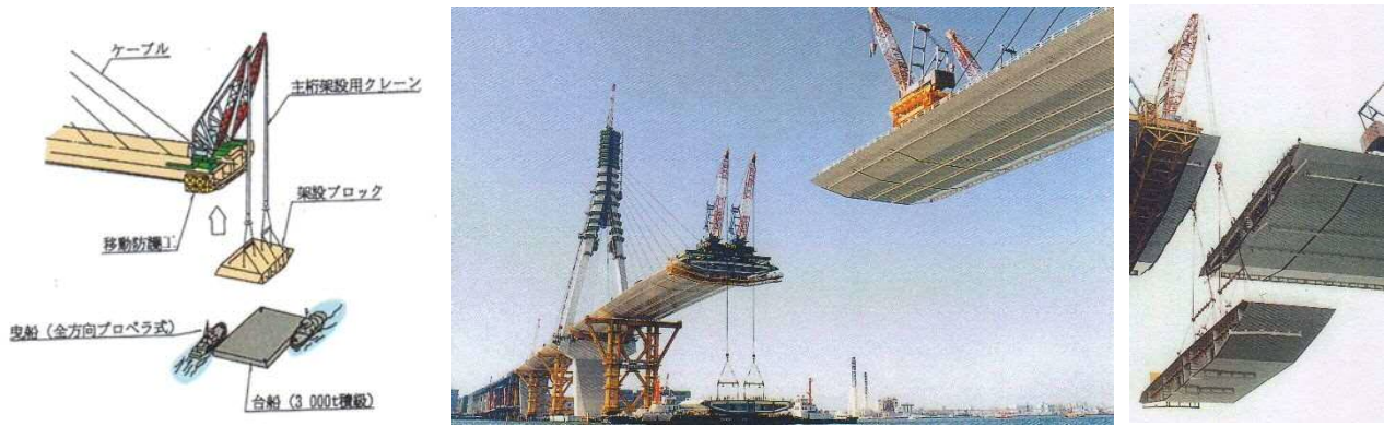
写真-3 鶴見つばさ橋架設状況
