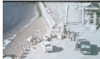
図 11. 和布刈神社の横での工事
