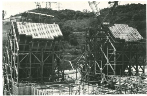
図 10. アンカレッジの施工
