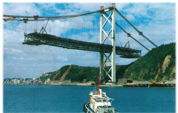
図 4. トラス式補剛桁を逐次剛結方式で架設
