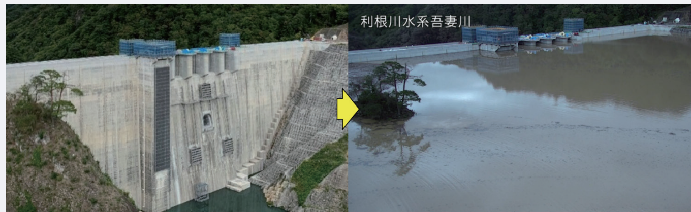
10月11日 状況写真 写真8 2019（令和元）年東日本台風に伴う貯水位上昇
