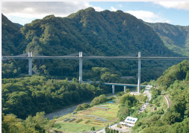
写真9 不動大橋（湖面2号橋）
