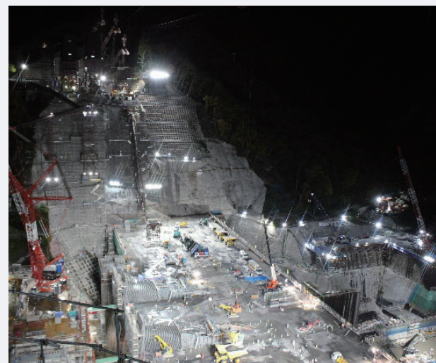
写真6 24時間施工状況（本体コンクリート打設）
