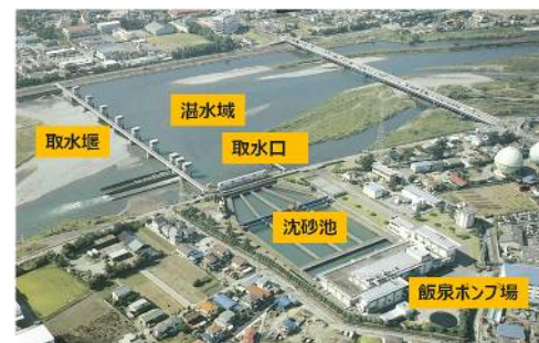
写真2 飯泉取水施設
