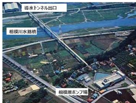
写真 5 相模川水路橋・相模原ポンプ場
