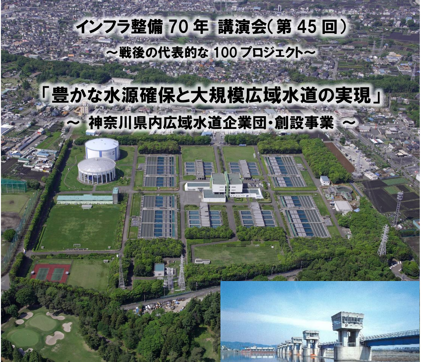
相模原浄水場
