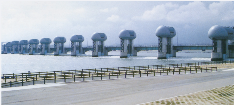
写真2 下流から見た長良川河口堰
