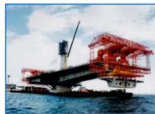
写真 9 張り出し架設
