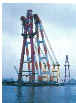
写真3 主塔の架設
