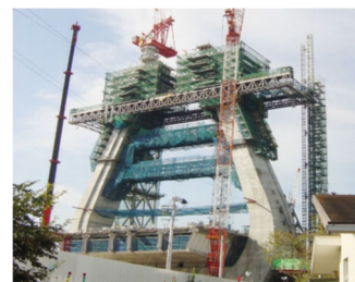
写真 6 クライミング足場
