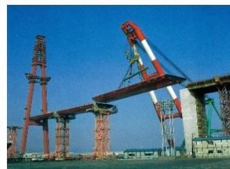
写真4 主桁の大ブロック架設
