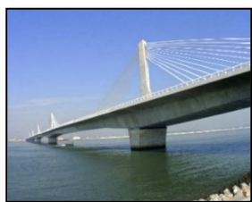
写真 7 湾岸揖斐川橋
