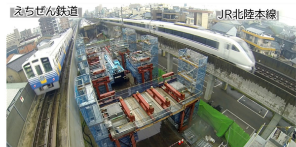
写真-1 えちぜん鉄道と北陸本線に挟まれた高架橋施工
