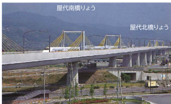
写真-3 屋代橋りょう（エクストラードズド橋）
