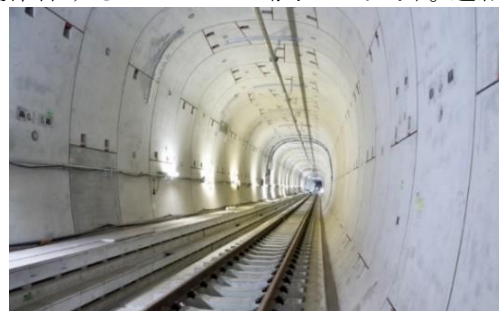
写真 4-1 単線複合円形断面トンネル
