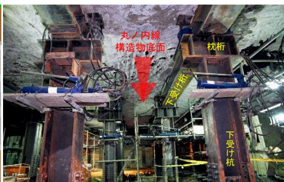
写真 3-3 アンダーピニング施工状況
