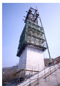
写真 7 永井川橋の施工
