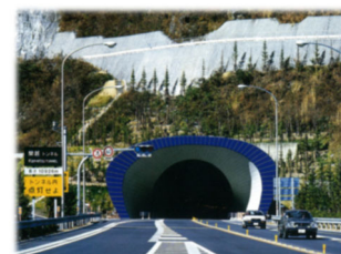
写真 3 関越トンネル入り口坑門
