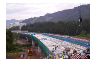
写真 15 橋梁床版取り替え
