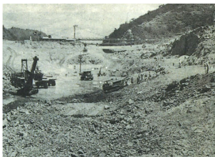
写真9 堤体河床部基礎掘削状況(1956年6月)
