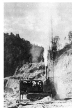
写真15 原石山掘削状況(ドリルマスター)
