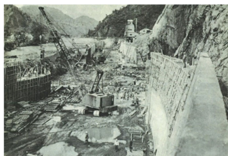
写真7 仮排水路堤体右岸部の工事状況
