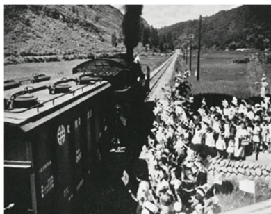
写真6 田子倉ダム工事専用鉄道（現在：JR 只見線）
