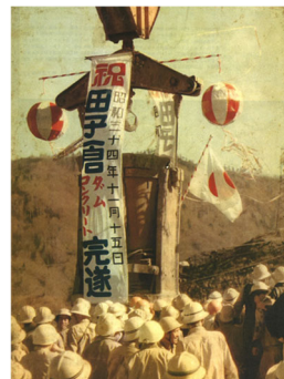
写真13 打設完遂式(1959年11月)
