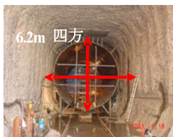
写真19 奥只見ダム穴あけ矩形断面
