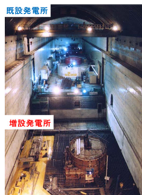
写真17 地下発電所拡張
