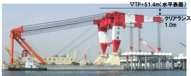
写真3 低頭起重機船によるジャケット据付
