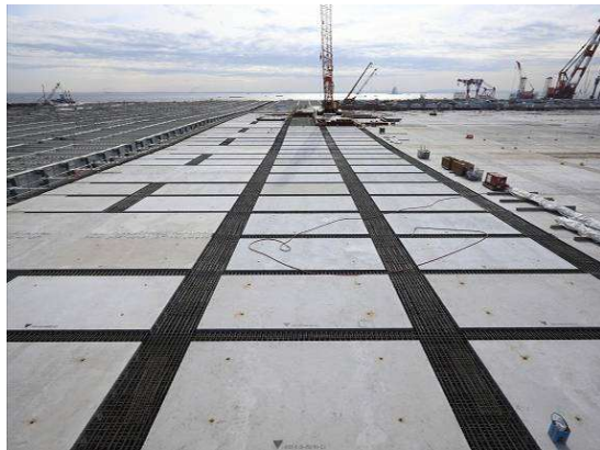
写真4 PCa床版施工
