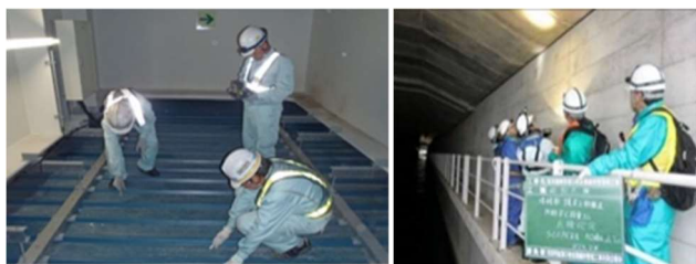
写真8 カバープレート内部点検廊(左) /接続部の点検(右)
