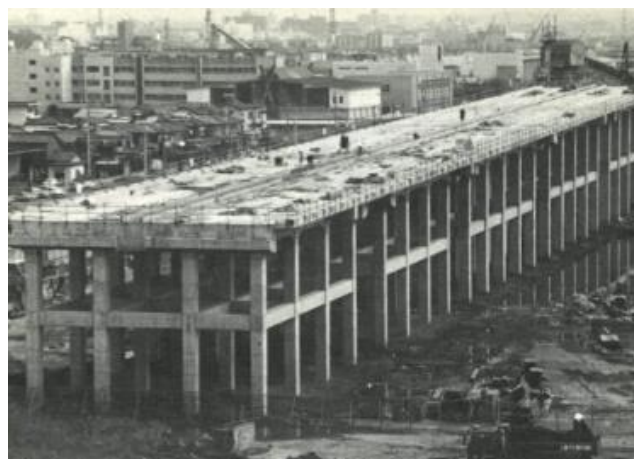
写真-4 戸田地区施工時の様子
