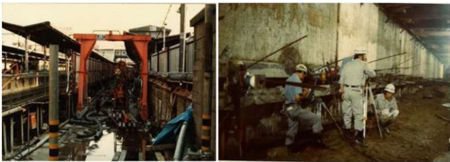
写真-2 施工状況（地下掘削、アースアンカー）
