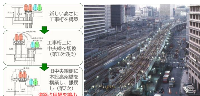
図-8 中央線重層化（線路の振り戻し）
