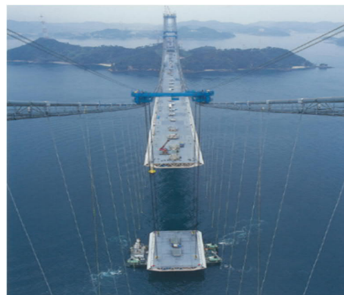
写真—8 自航台船による補剛箱桁直下吊架設
