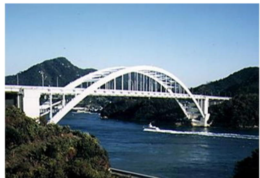
写真—4 大三島橋
