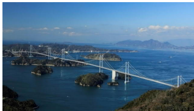
写真—6 3連吊橋の来島海峡大橋
