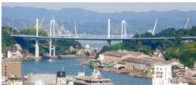
写真-1 新尾道大橋(手前)と尾道大橋(奥)
