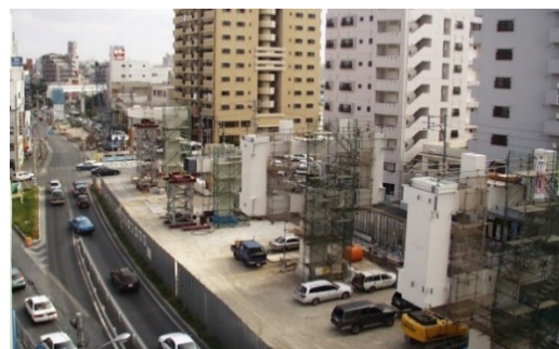
写真-8 モノレール軌道用橋脚の建設状況
