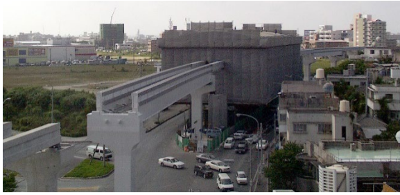
写真-9 おもろまち駅駅舎建築工事の状況
