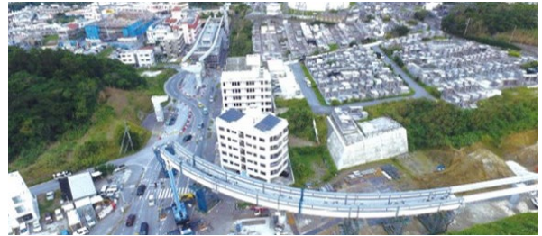
写真-11 延長区間(経塚付近)鋼桁架設の状況
