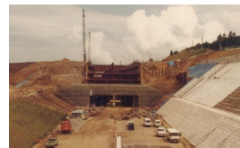
写真 17 有磯海 SA 函体構築
