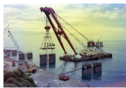
写真5 親不知海岸高架橋の橋台設置
