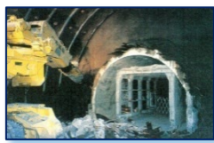
写真 13 高の峰トンネル
