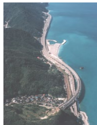
写真4 親不知海岸高架橋
