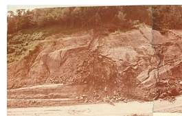
写真 16 加賀地区地滑り
