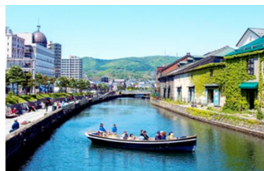
写真5 完成した臨港線散策路と小樽運河
