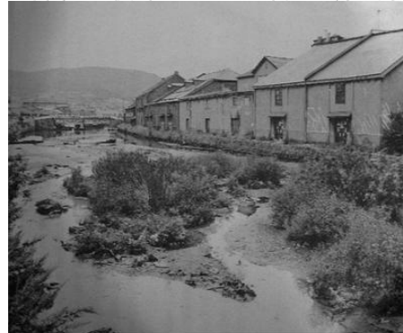
写真2 ヘドロと土砂で埋まっていた整備前の小樽運河
