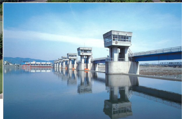
上:相模原浄水場、右下:飯泉取水堰 写真提供:神奈川県内広域水道企業団
