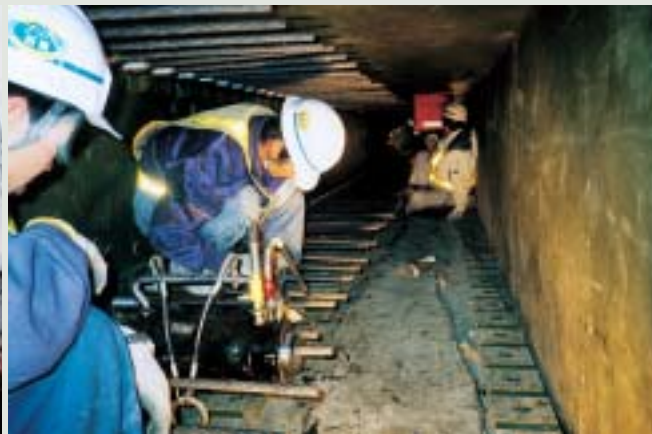
写真2 - 鋼製エレメント内横締め施工
