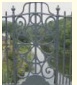
橋の中央にある高欄
