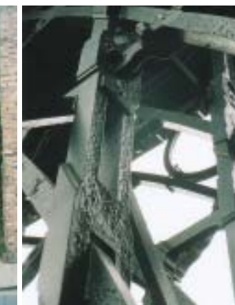
写真5 - 橋の部材接合部
