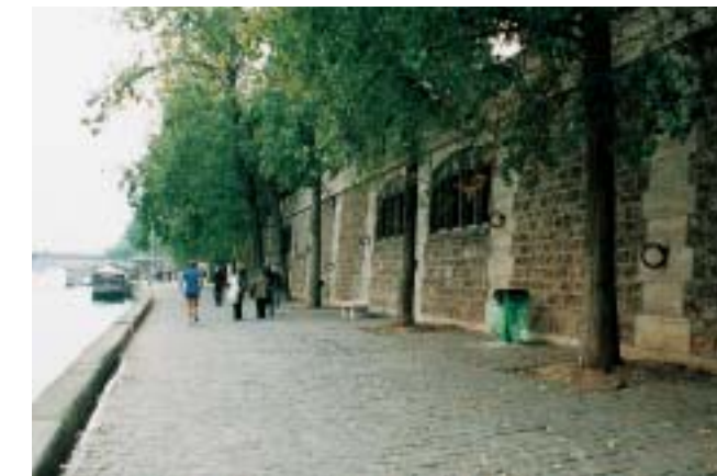
写真4 - 直立の護岸であるが、石積みのためか威圧感が少ない
