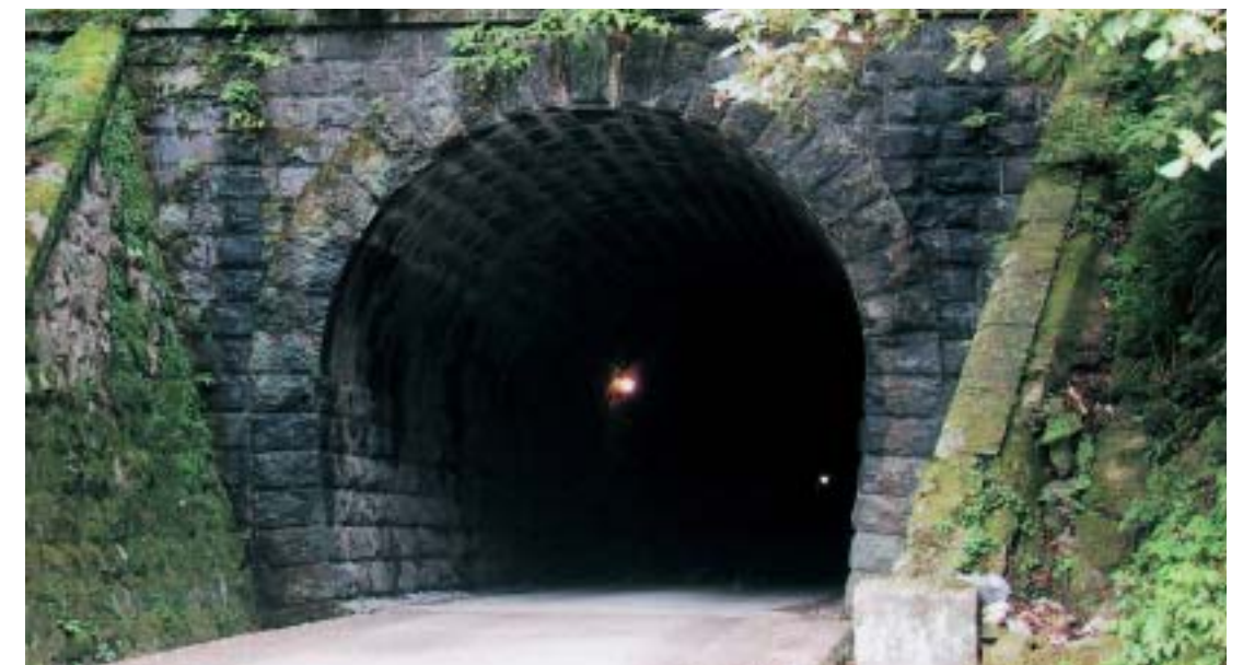
写真4 - 旧天城トンネル南口(河津町側)
