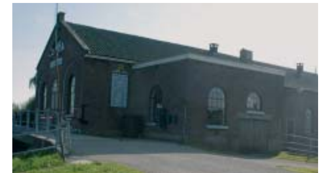
写真4 - 蒸気機関のポンプ場
