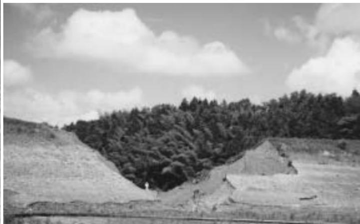
写真2 - 1997年台風9号によって幅40.3mにわたり決壊した貯水量10万m<sup>3</sup>の麻生ため池(山口県阿武郡むつみ村)
