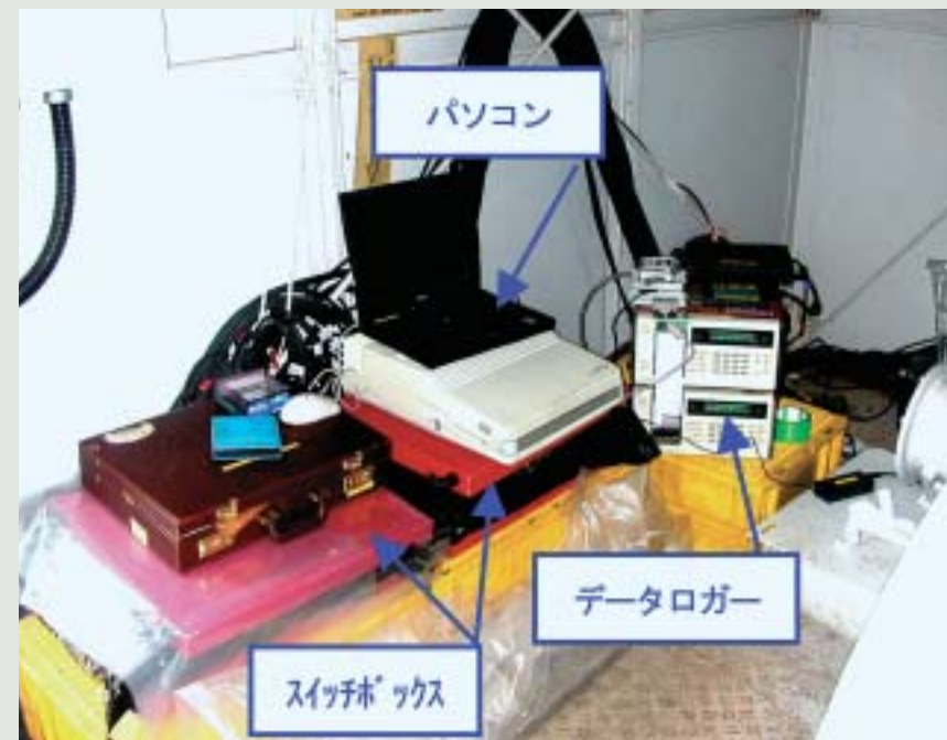
写真2 - 計測機器設置状況
