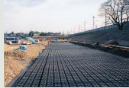
写真8 - 施工中の貯水槽
