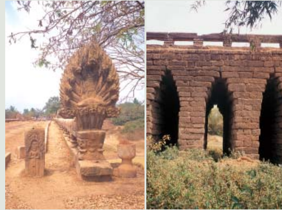
写真2[前頁上]-「幻」の石橋スピアン・プラプトスの全景 シムリアップから国道6号線を60kmほど東にいったあたりにある 乾季でも片道2時間ほどかかる 写真3[左上]-親柱の位置には、水をため財産を守るといわれるコブラの頭が4つ残されている お線香や灯明を上げる人もいる 写真4[右上]-せり出し工法の開口部 スパンは狭く、スリット状である 写真5[左下]-橋を通る牛車 国道といっても舗装されていない田舎道だ 雨季になると路面が滑り通行が難しくなる 写真6[右下]-シムリアップ市街 アンコール遺跡観光の母都市として栄えた 古い街並みが魅力
