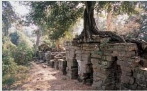
写真1 - スピアン・トマ アンコール遺跡群の一角(アンコール・トムの東大門の東側)にある、一部が損壊した石橋 規模は小さい
