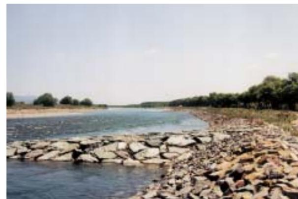
写真2 - 吉野川特産の青石でつくられた水制の石組み
