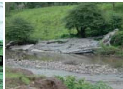
写真3 - ハリケーン「ミッチ」による洪水で流失した橋の残骸
