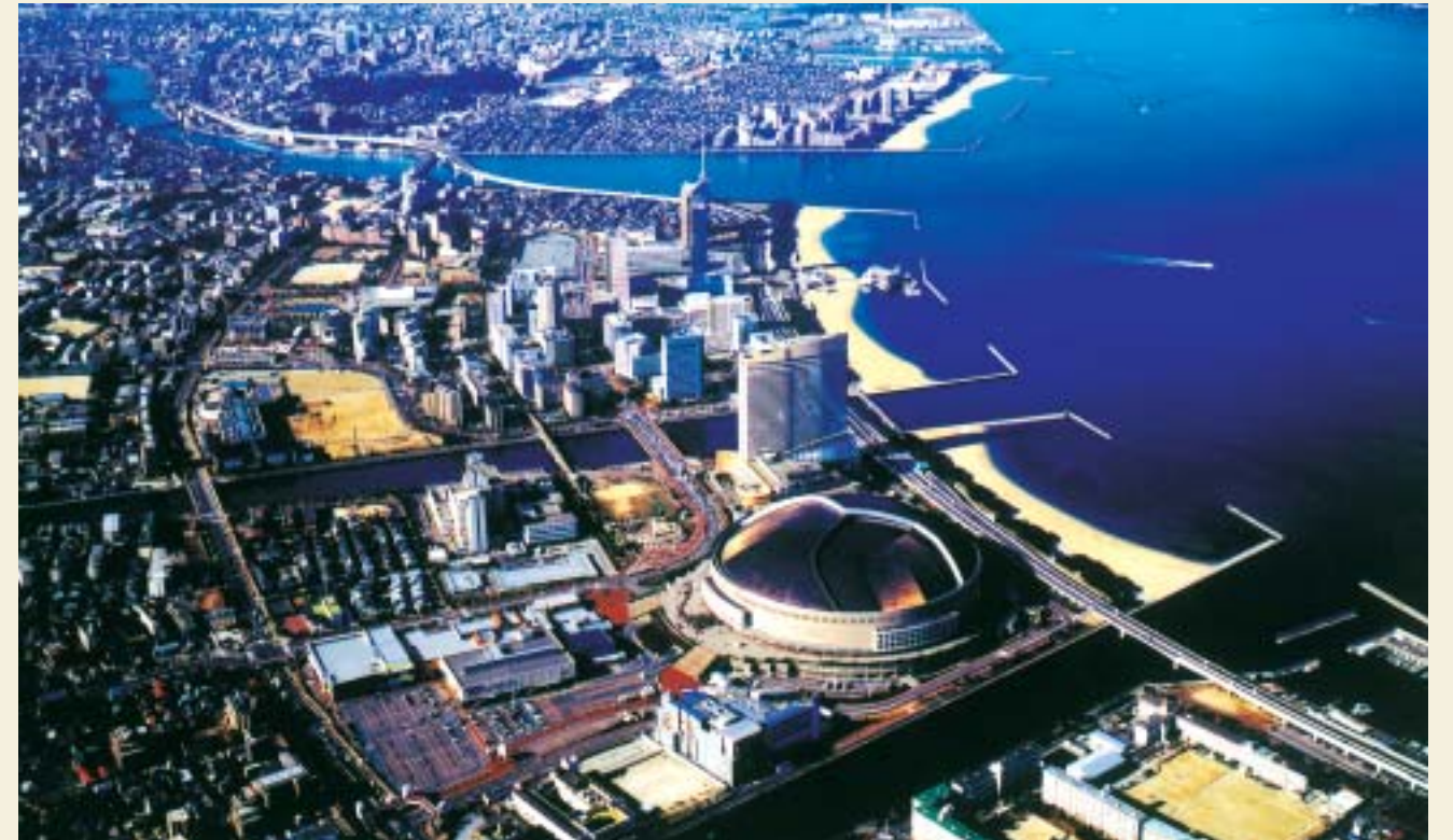
写真4 - 建設省(現国土交通省)の都市景観大賞も受賞した「シーサイドもち」(写真提供:福岡市港湾局)
