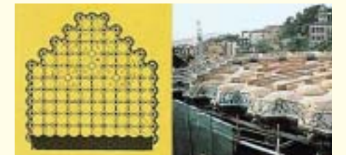
■中央広場を支えるキューブラの補修状況
