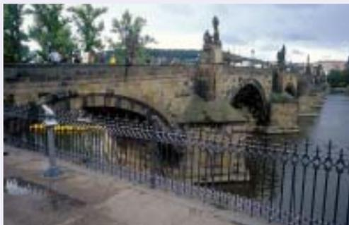
エッタ橋の上流側に建造した。新しい橋は1350年頃に着工され、ジュリエッタ橋より橋面を7m高く、長さ515m、幅9.5mとした。これが現在のカレル橋である。橋がまっすぐでないのは、当時家を避けて造ったためである。
