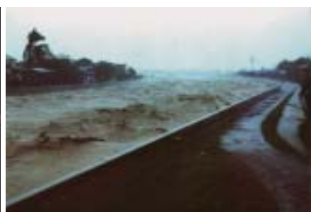
■写真17、18—2003年7月17日に再びオルモック市を洪水が襲った
