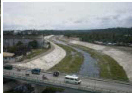
■写真11—河道改修後のアニラオ川
