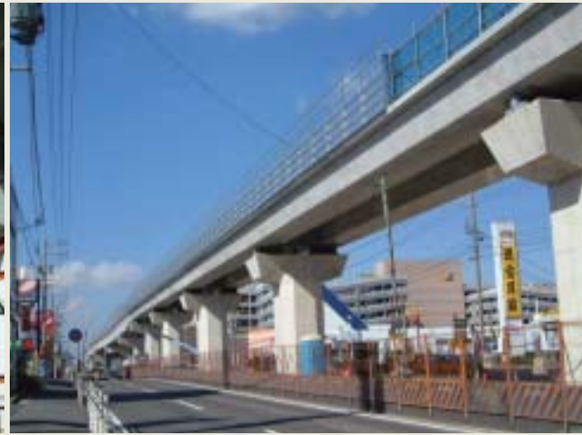
■写真3—高架一般部の整備状況
