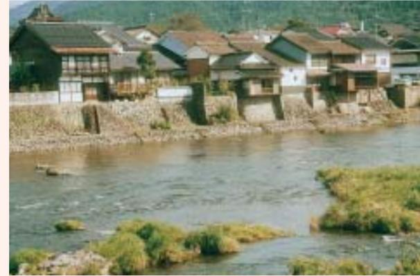
であり、「ガンギ」と呼ばれる石段とともに、700mに渡って完全に残されている。巻石構造とは、柱や構造物の土際の部分を石で巻きめぐらし、腐れ留めをしたものをいう。旭川では古い町並みと相まって、独特の景観を形づくっている。
