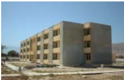
■写真2—JICA緊急復興支援(筆者が参加)で修復された
