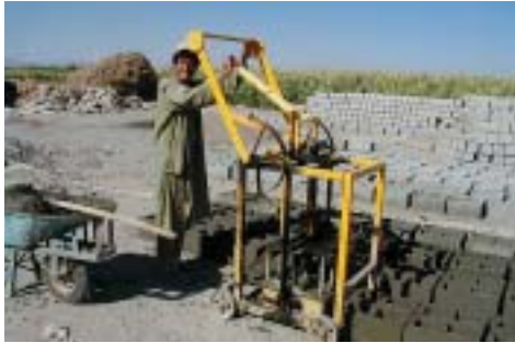
■写真7ーコンクリートブロックを作る(カンダハール)
