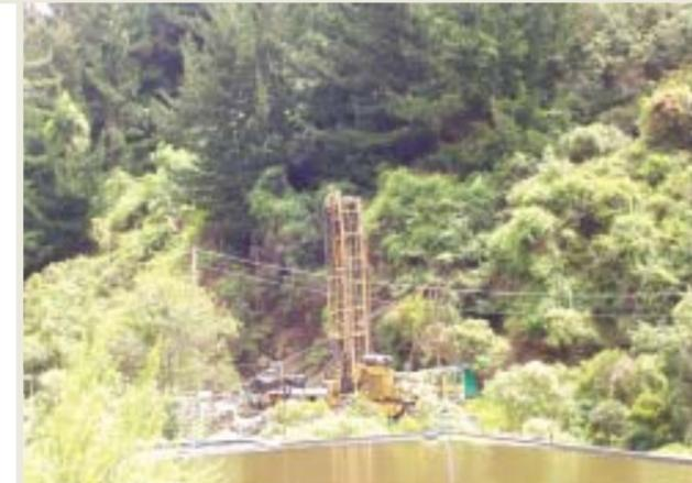
■写真5—人工涵養井戸の掘削状況(手前は沈砂池)
