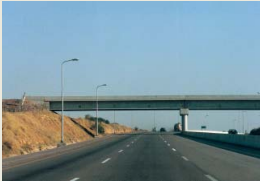
■写真1—パキスタンのAH1号線（イスラマバード～ラホール高速道路）
