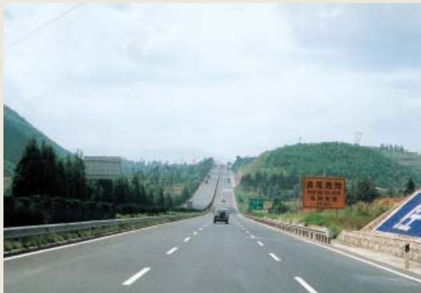
■写真2—中国昆明近郊のAH3号線（昆石高速道路）
