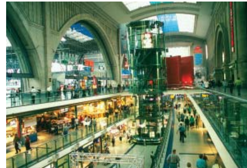
■写真3—主要な鉄道駅を拠点とした重点的な空間整備は、ヨーロッパでも着目されている。その際に新宿や渋谷をはじめとするわが国の古典的事例が「手本」とされていることを忘れてはならない。写真はドイツ・ライプツヒ中央駅の事例。美しい建築物を残しつつ市の事業としてコンコースを掘り下げて多層の商業空間とした
