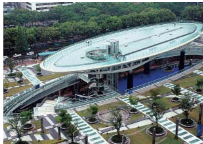
■写真8—イベント空間、商業空間、公園がバスターミナルと併せて整備された名古屋市栄の「オアシス21」。バスの待ち合いスペースなどにはまだ改善の余地が大きい。都市に非常に大きなインパクトを与えるTODの好例といえよう
