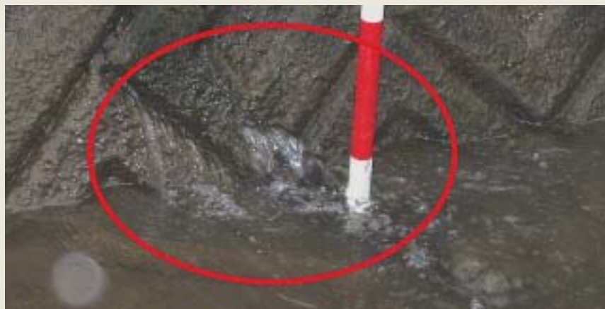
■写真6—コンクリートブロックからの湧水(H16.2.2撮影)
