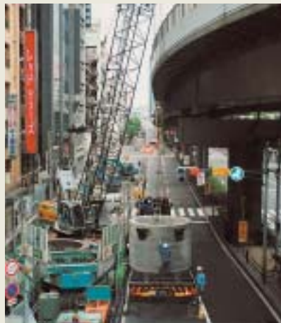
■写真2—PCウエル施工状況 (P11橋脚) 大阪市より提供
