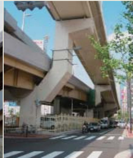
■写真6—完成写真既設橋脚の改築
