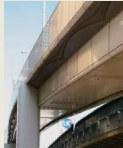
■写真4—完成写真鋼上部工 (ルーバータイプ化粧板)
