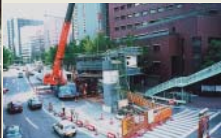
■写真3—鋼上部工架設状況 (P13橋脚～A2橋台) 大阪市より提供
