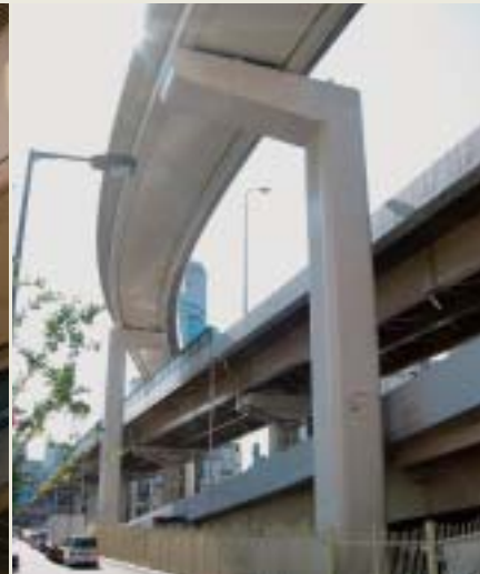
■写真5—完成写真鋼製橋脚
