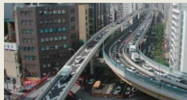
■写真7—完成写真 (全景) 大阪市より提供
