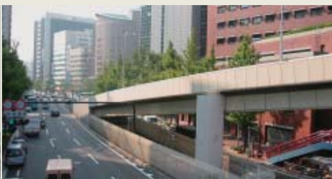
■写真8—完成写真 (終点部)
