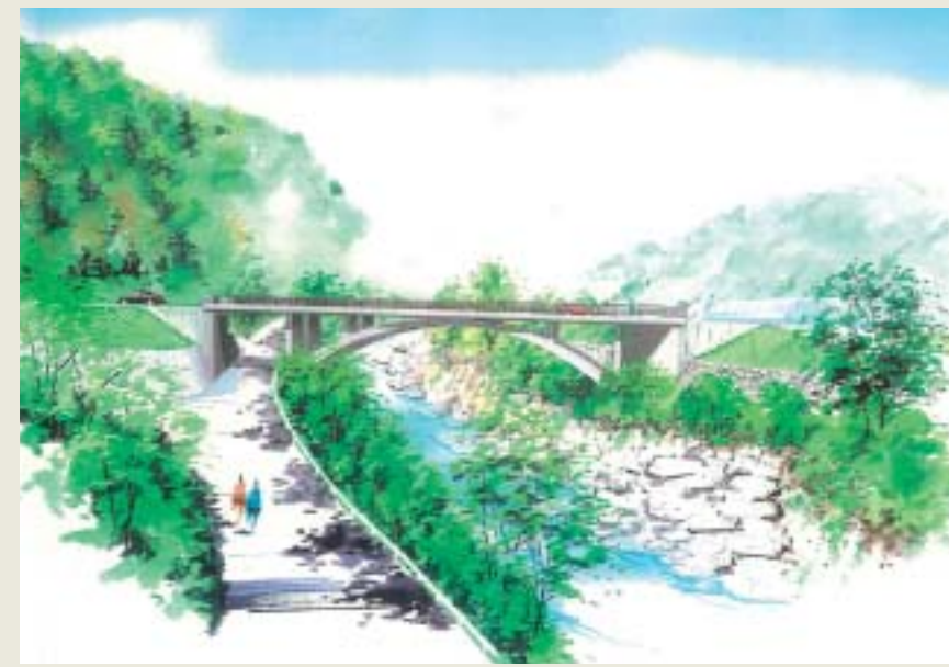
RCコンクリートアーチ橋
