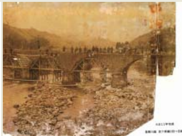
■写真3—当時の石橋の架設風景（大正11年）
