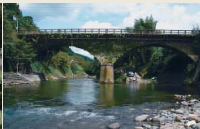
二連の寄口橋(大正9年竣工)「ふ」
