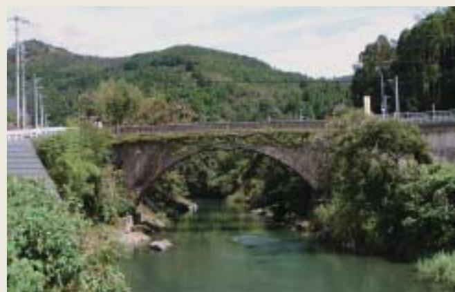
一連の洗玉橋(明治26年竣工)「ひ」
