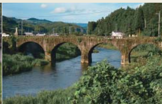
四連の宮ヶ原橋(大正11年竣工)「よ」
