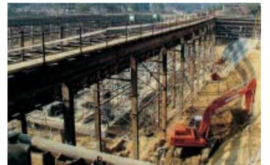
■写真7—開削工法で進められた地下鉄区間の施工状況(2002年当時)
