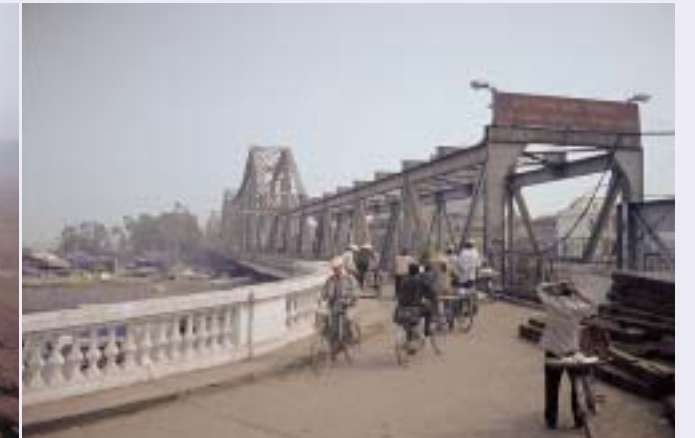
■写真3—ロンビャン橋 鉄道橋だが歩行者と自転車は通行できる
