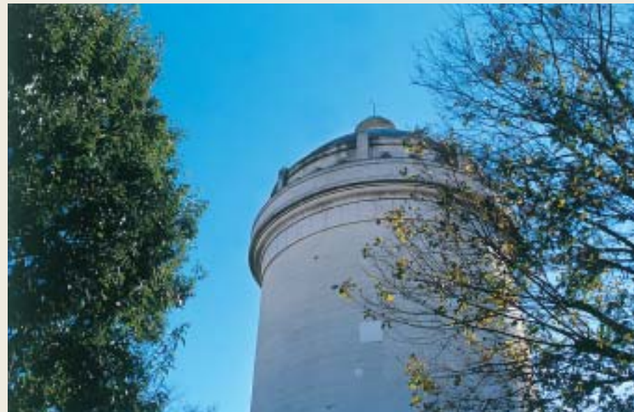
■写真1[前頁上]—野方給水塔、街の顔として親しまれている ■写真2[前頁下]—生活道路となっている荒玉水道道路 ■写真3[左上]—水の塔公園にたたずむ野方給水塔 ■写真4[右下]—取り壊しが決まっている大谷口給水塔
